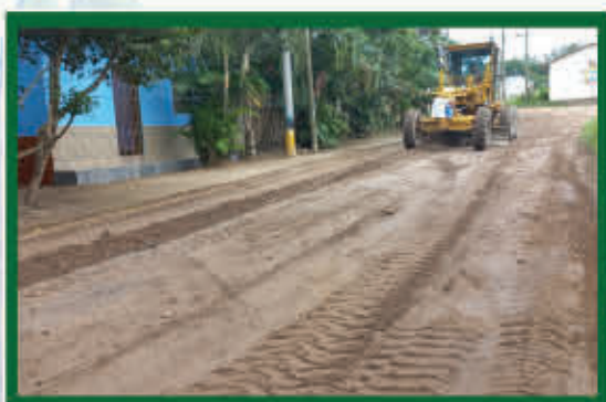
Reparacion de calles Col. Los Angeles
