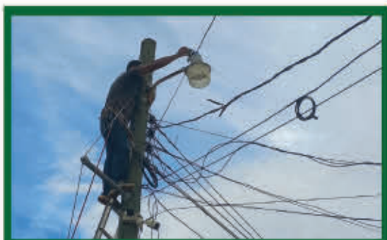
Reparacion de lamparas de alumbrado publico
