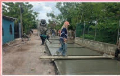
Avanzamos con paso firme en la pavimentación comunidad de La Fines
