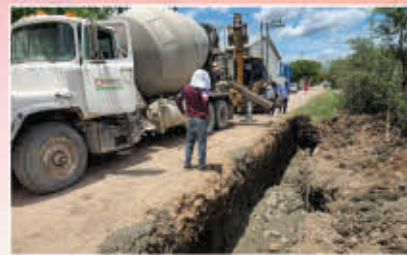
Construcción del muro de confinamiento como parte del proyecto de la calle de concreto hidráulico en el barrio Plaza Marina
