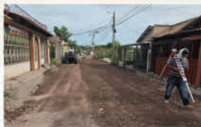
Pavimentación de la Residencial La Panchita
