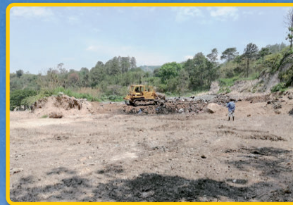
Mantenimiento Crematorio Municipal
