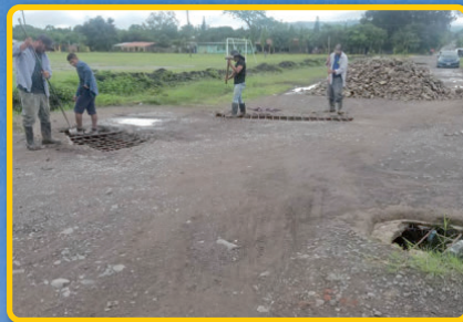
Reparación de cajitas puentes en la plaza de la feria.
