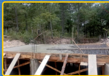
Construccion de Cajas Puente
