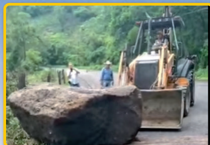
Remocion escombros Carretera a Frontera El espino
