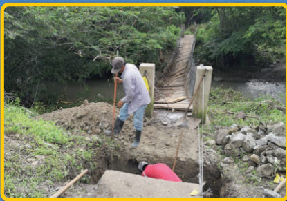
Reparacion de puente la Barranquilla hacia Sagrado Corazón
