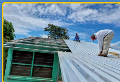
Reparacion techos de escuelas
