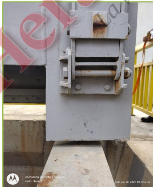
Ilustración 3: Sin tocar nada, en la imagen se puede observar la separación de la Compuerta de la Unidad No.2 utilizando los yugos de apoyo de la Unidad No.1.
