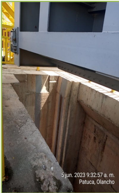
Ilustración 2: Se observa la Compuerta de Mantenimiento de Bocatoma de la Unidad No.2 sin los yugos o vigas de apoyo.
