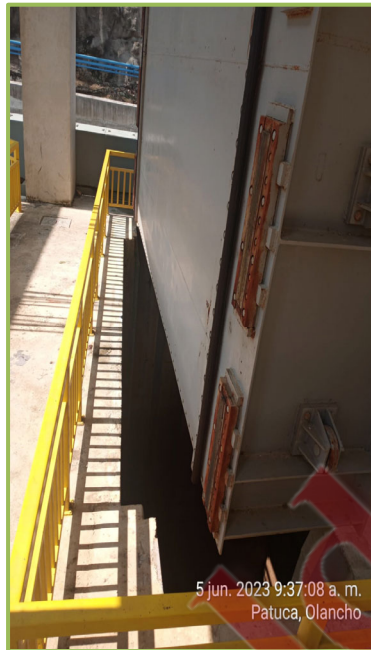
Ilustración 2: Se observa la Compuerta de Mantenimiento de Bocatoma de la Unidad No.2 sin los yugos o vigas de apoyo.
