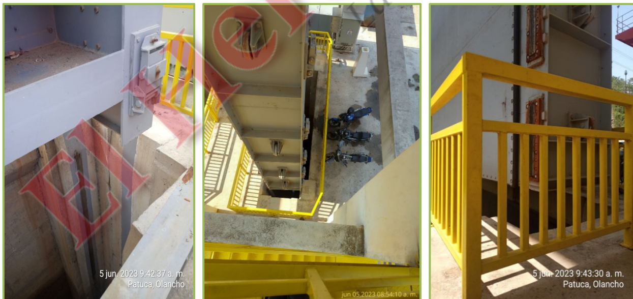
Ilustración 1: Se observa la Compuerta de Mantenimiento de Bocatoma de la Unidad No.2 sin los yugos o vigas de apoyo.
